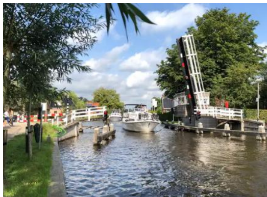
Een brug in de Kalenbergergracht
